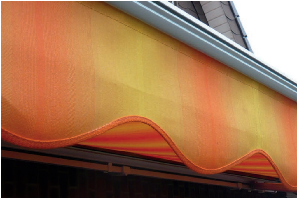
9.1.19 Zulässige verpackungsbedingte Faltenbildung im Volantbereich
